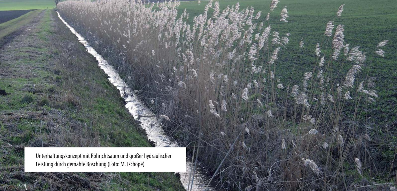
Unterhaltungskonzept mit Röhrichtsaum und großer hydraulischer Leistung durch gemähte Böschung (Foto: M. Tschöpe)
