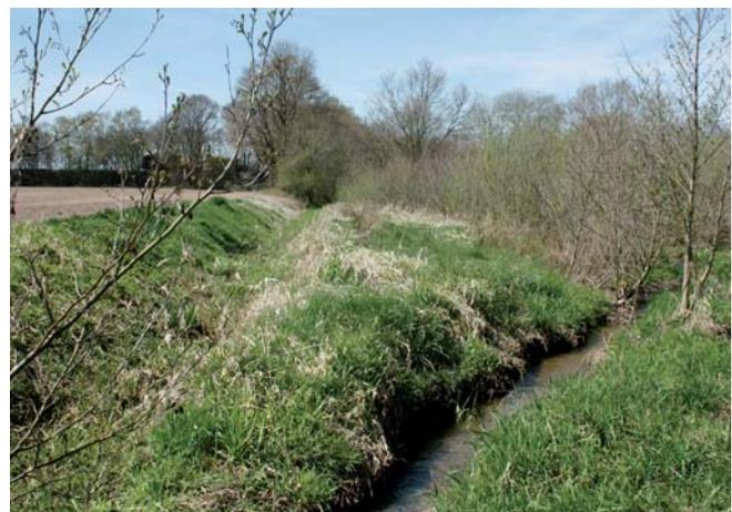
Die umliegenden Flächennutzungen verhindern oftmals die Anhebung der Gewässersohle und Änderungen der Wasserspiegellagen. In diesem Beispiel wurde die Sohlage beibehalten und eine Aufweitung durch Abtrag des Oberbodens über Mittelwasserlage wirkt als „Sekundäraue“. Sie bietet dem abfließenden Hochwasser Raum und stellt die hydraulische Leistung im Hochwasserfall sicher. (Foto: U.A.N.)
