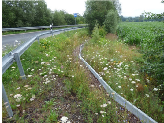
Abb. 14 Ruderalvegetation nördlich des Plangebietes im Bereich des Zubringers.
