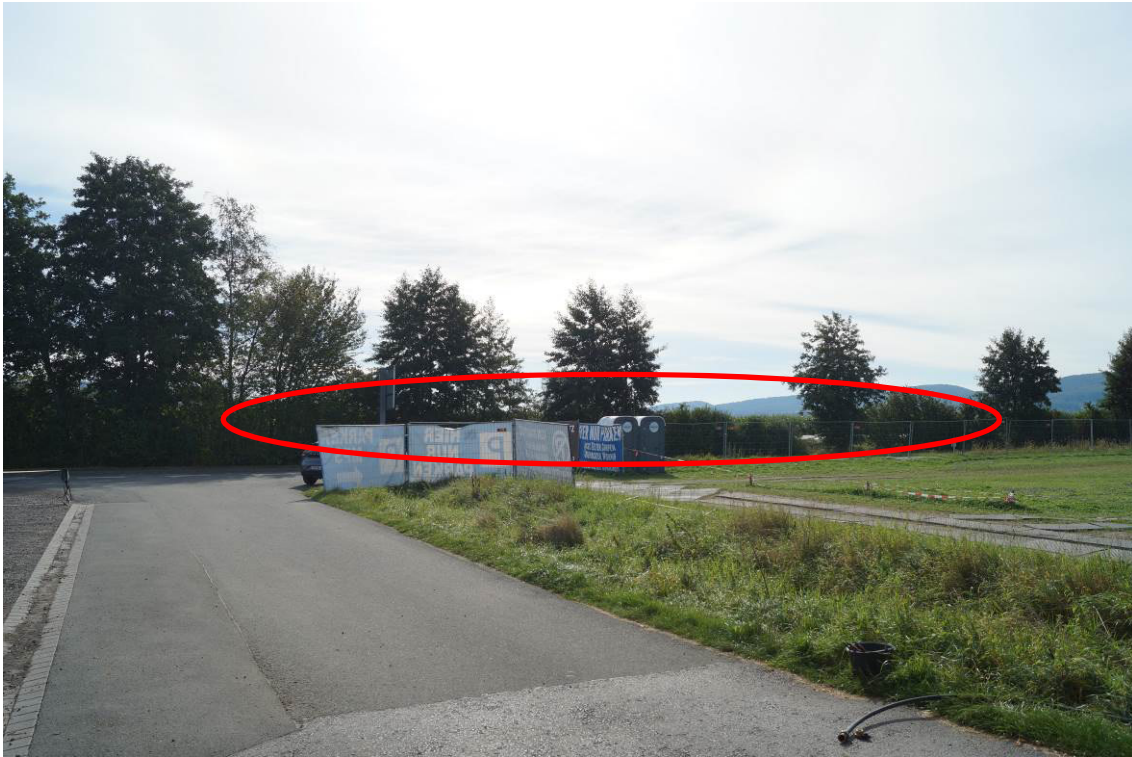
Abb. 23 Blick von dem südlich gelegenen Parkplatz auf das Plangebiet (rote Markierung) (Nahbereich).
