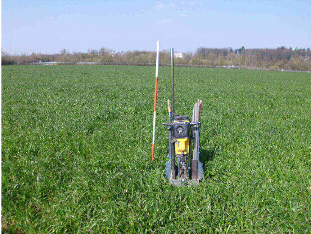
Bild 5: SE-Seite Gebäude, Sondierung S 5, Blick nach Norden
